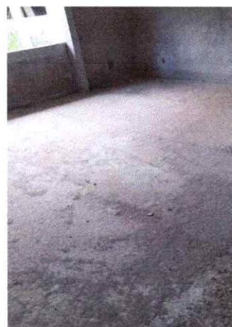
FOTOS 07, 08, 09, 10, 11, 12 REVESTIMENTO CAMADA IMPERMEABILIZADORA
